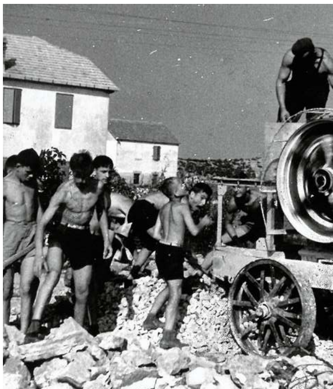
Učenici iz Varaždina na dobrovoljnom radu - asfaltiranju ceste, Murter, ljeto 1963.
